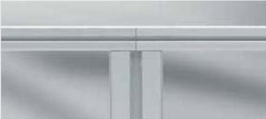
Die Verlängerung von Profilen sollte nur mit den entsprechenden Verbindungselementen ausgeführt und an der Nahtstelle möglichst zusätzlich unterstützt werden.
